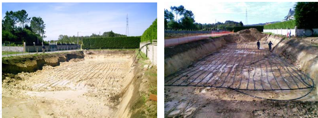
Captación horizontal de 1500 m de tubería, 900 m 2 de superficie y 2,5 m de profundidad
