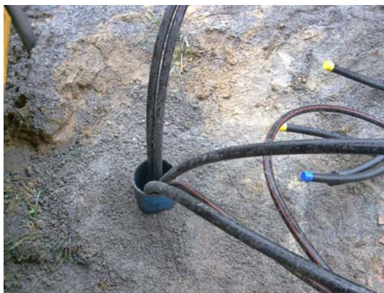
Perforación geotérmica vertical a 140 m de profundidad con 2 sondas de doble U y tubo de inyección de la mezcla geotérmica
