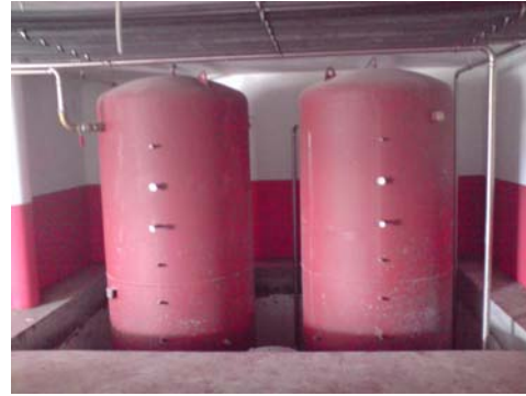
Calefacción geotérmica en vivienda unifamiliar con almacenamiento de calor en depósitos de inercia (2 X 5.000 l) para funcionamiento en período de discriminación horaria reducida (anteriormente tarifa nocturna).
