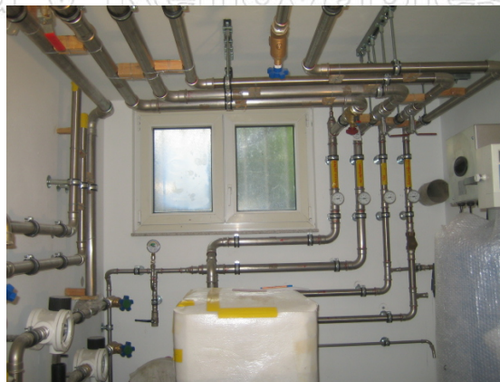
Instalación geotérmica en fase de ejecución
