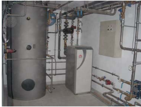
Calefacción geotérmica en vivienda unifamiliar con almacenamiento de calor en depósitos de inercia (2 X 5.000 l) para funcionamiento en período de discriminación horaria reducida (anteriormente tarifa nocturna).
